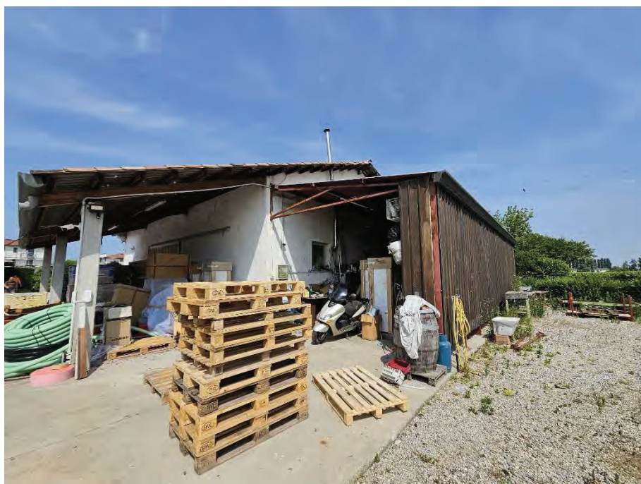
VISTA ESTERNA MAGAZZINO
