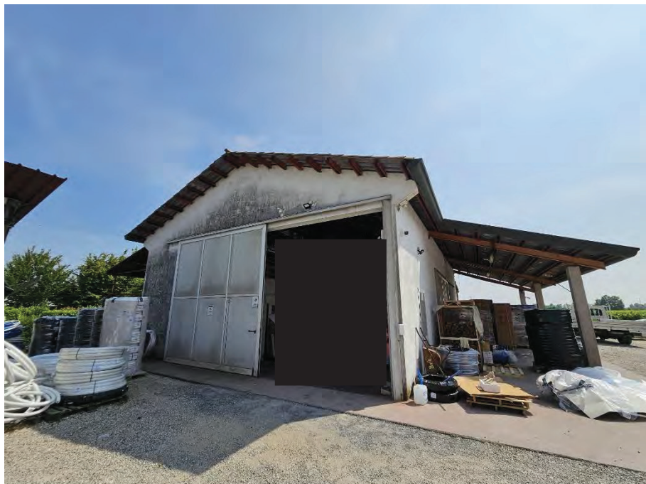
VISTA ESTERNA MAGAZZINO
