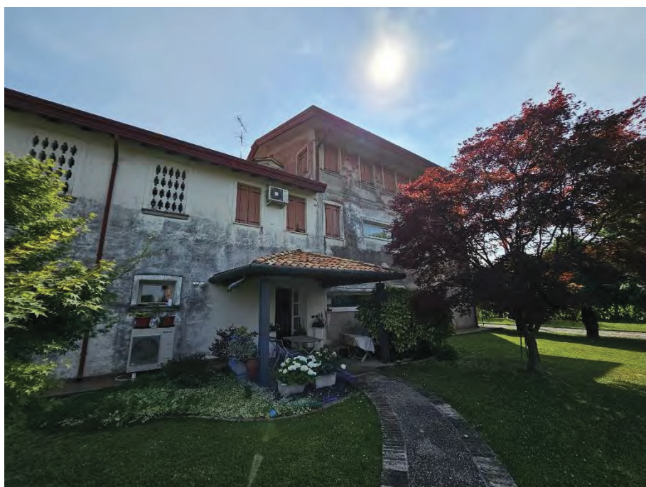
VISTA ESTERNA FABBRICATO RESIDENZIALE / UFFICI LATO NORD
